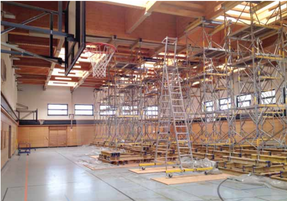
Wegen Mängeln gesperrte Sporthalle Sredzkistraße - Foto: Constanze Siedenburg
