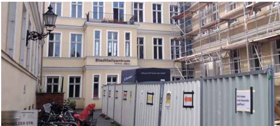
Erweiterungsbau des Stadtteilzentrums Pankow für ein breiteres Angebot Foto: Sabine Wagner
